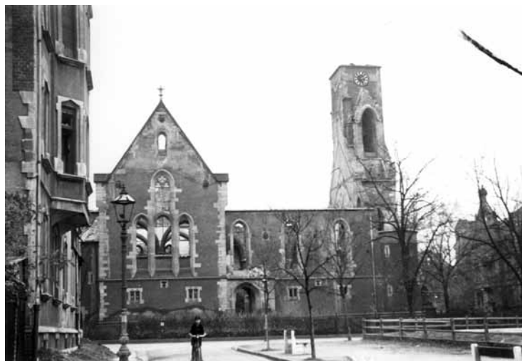
Blick vom Riegerplatz auf die zerstörte Martinskirche
